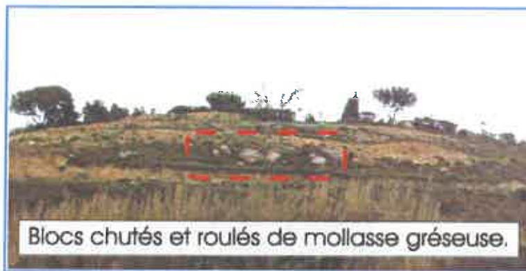
Photographie de blocs de molasse gréseuse, chutés et roulés – Parcelle n° 323 et 315. Lieu-dit "Les Clauzes".
