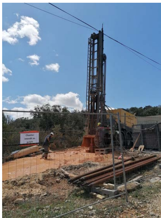
Forage de reconnaissance à Argelliers
