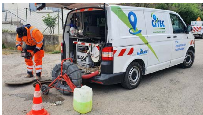
Intervention de la CITEC pour curage du réseau assainissement dans le cadre du marché d'hydrocurage.
