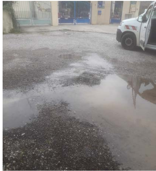
Fuite visible au Pouget en mars 2022.
