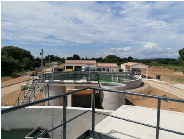
Nouvelle station d'épuration à Aniane, quelques jours avant la mise en service.
